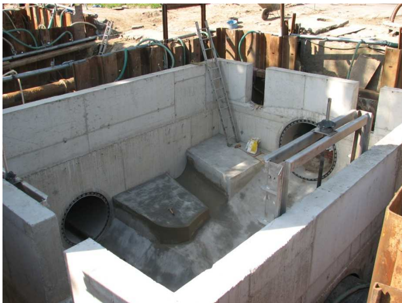
Komora połączeniowa kolektorów A i D
