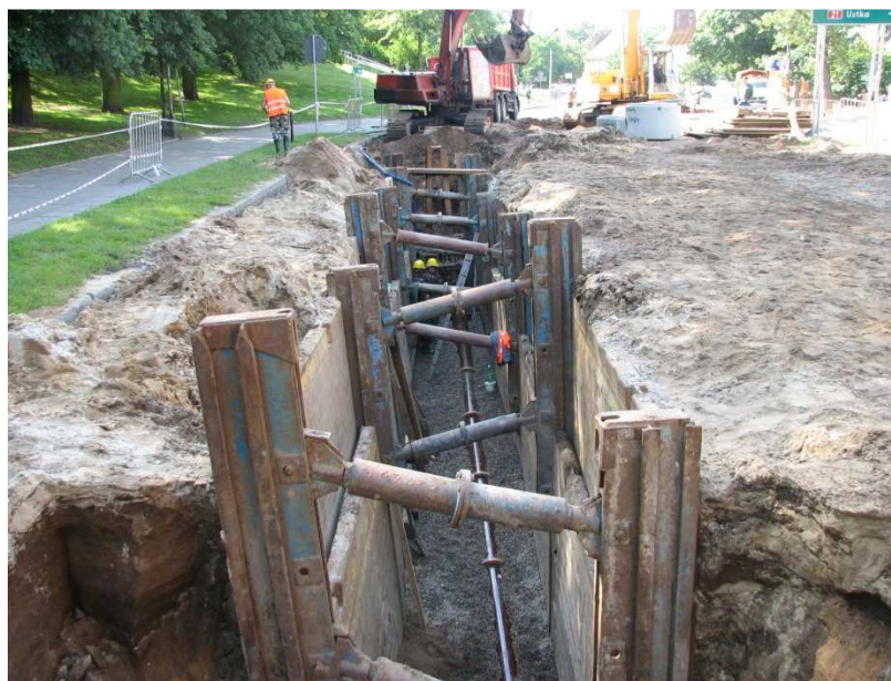
Budowa kanalizacji w ul. Kaszubskiej
