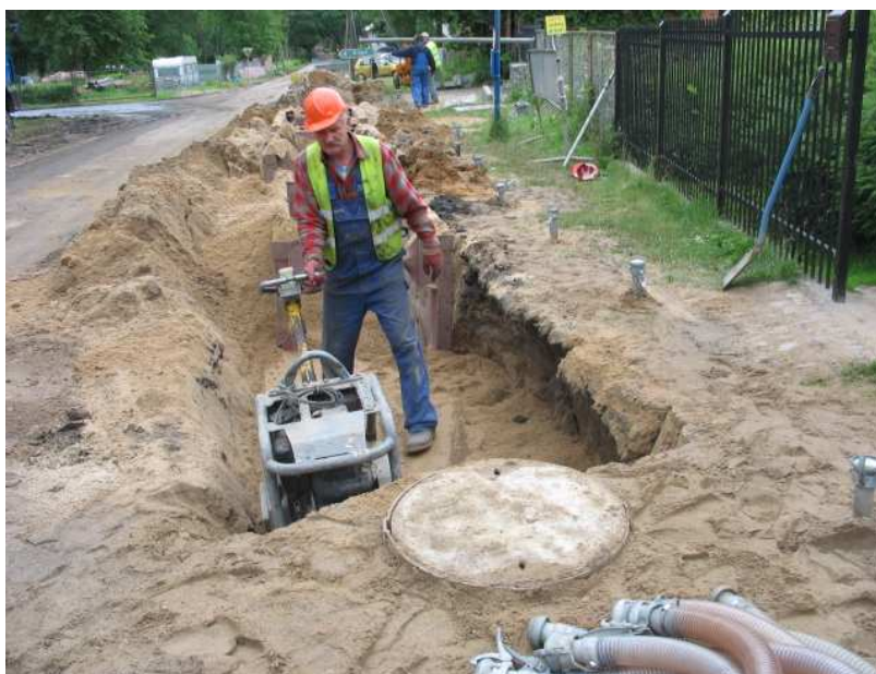
Zagęszczaniem gruntu w wykopach po robotach montażowych kanalizacji sanitarnej w Kusowie
