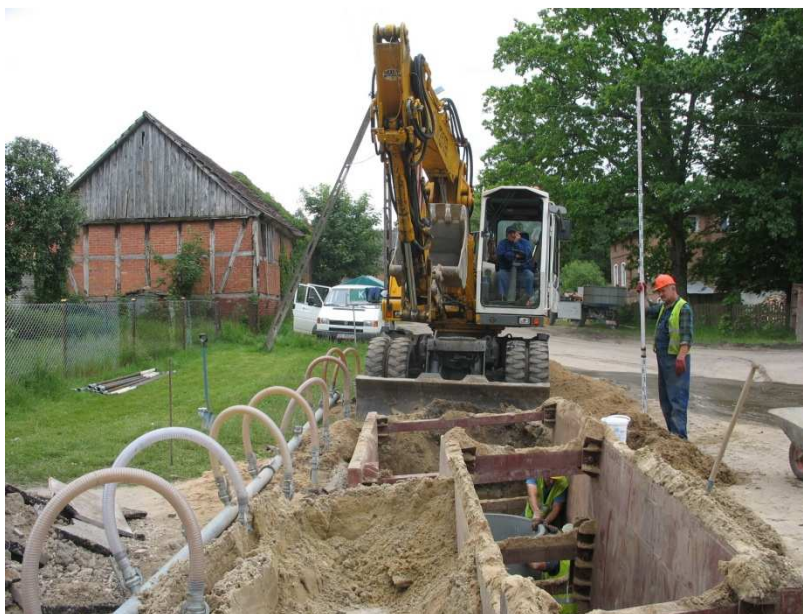
Roboty montażowe przy budowie kanalizacji sanitarnej w miejscowości Płaszewko
