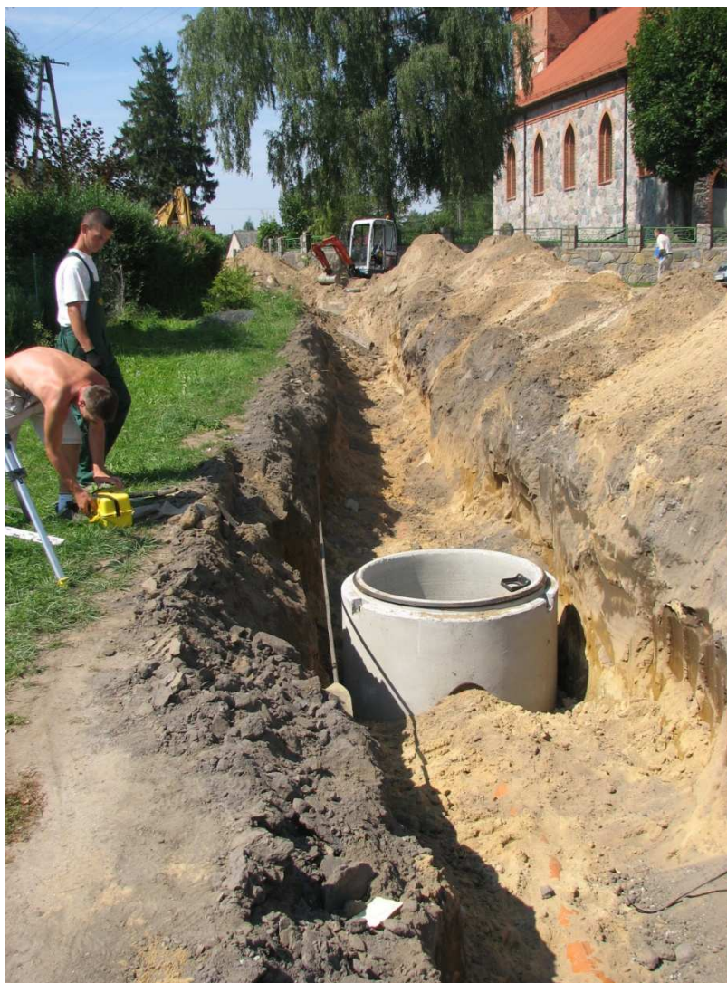
Prace w Kwakowie
