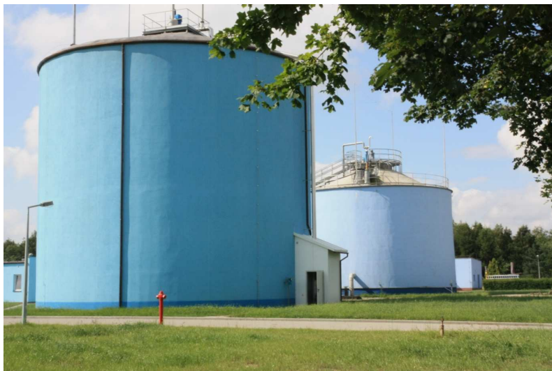
Komory fermentacyjne w słupskiej oczyszczalni ścieków
