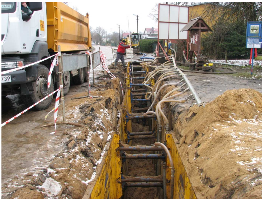
Prace w Kuleszewie
