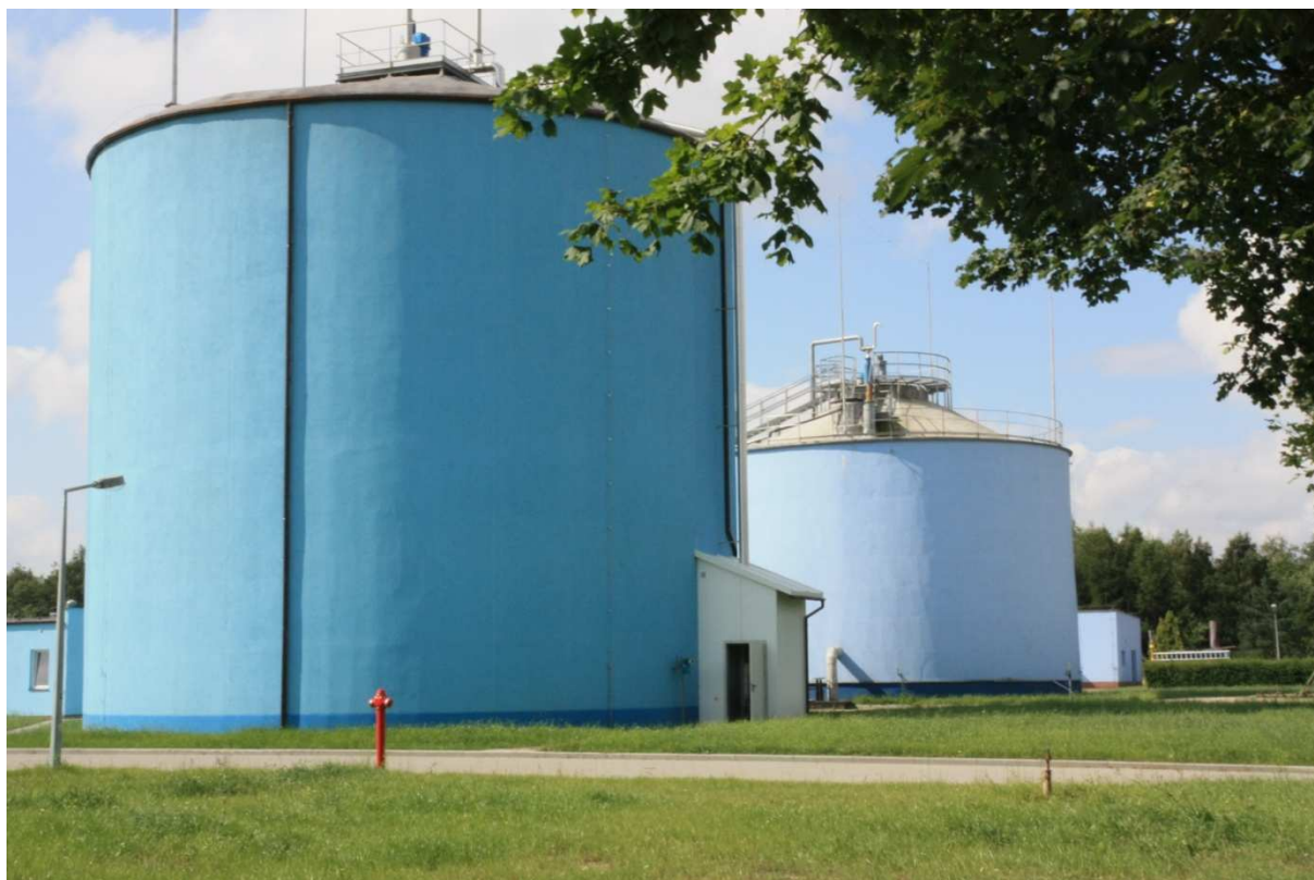
Komory fermentacyjne w słupskiej oczyszczalni ścieków
