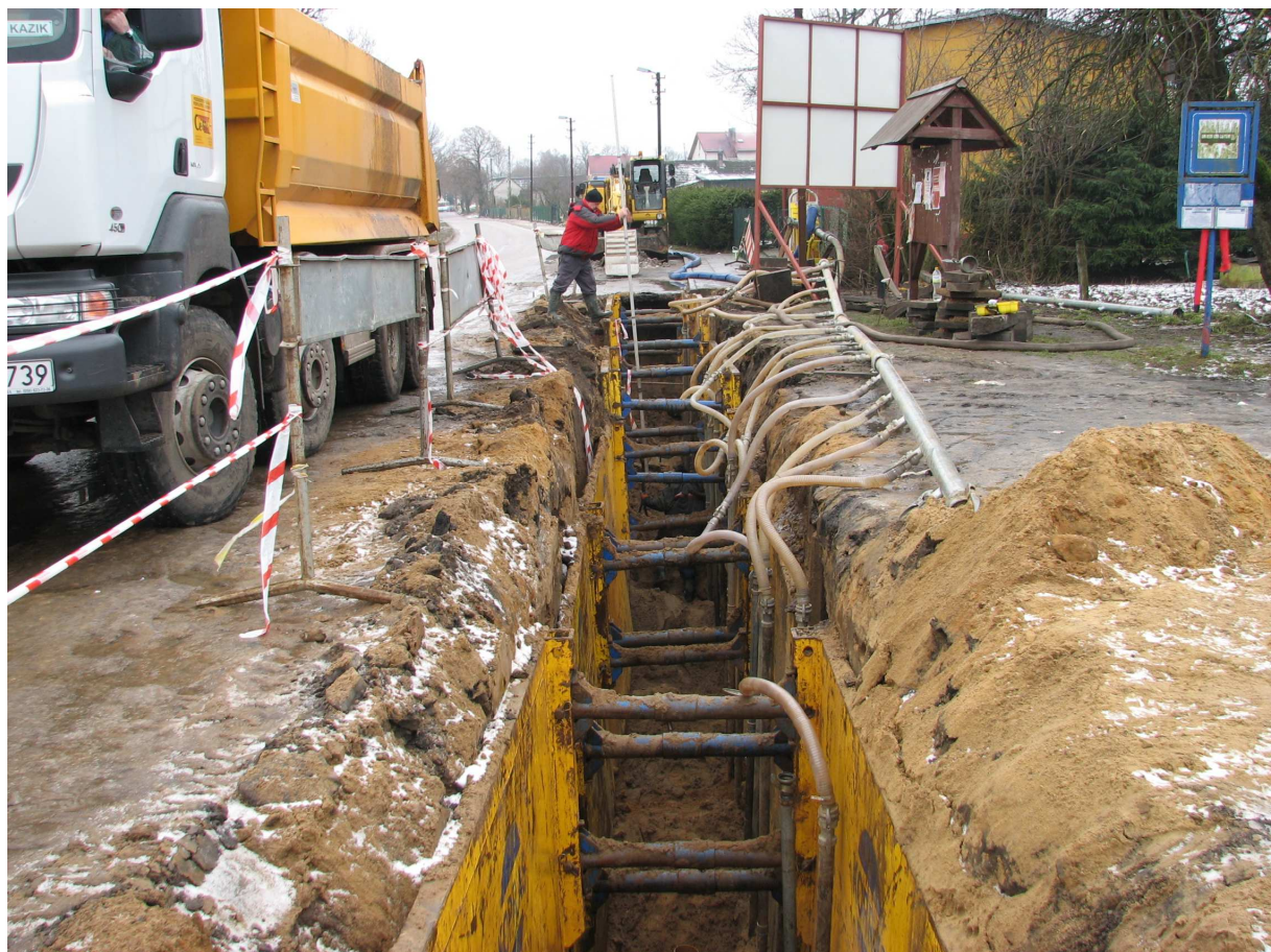
Prace w Kuleszewie
