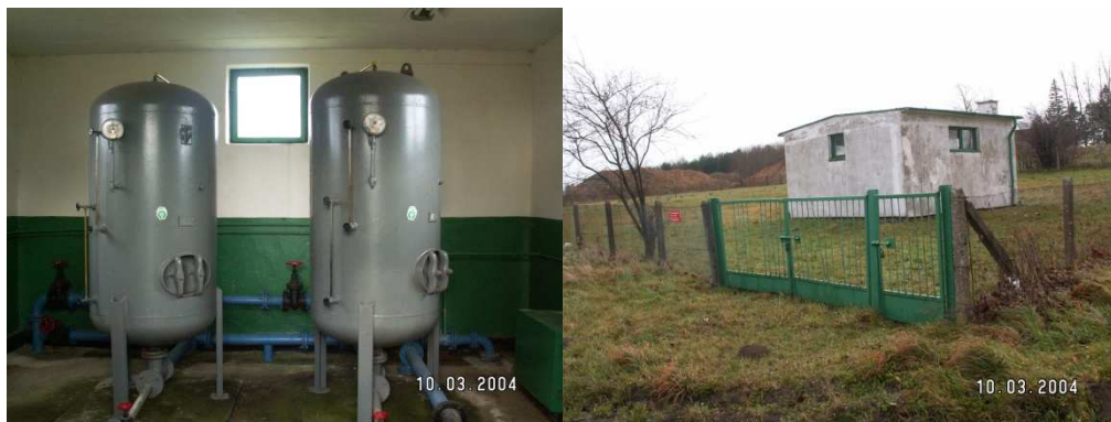
Rysunek 1 Elewacja budynku i zbiorniki hydroforowe w SUW Komitowo
