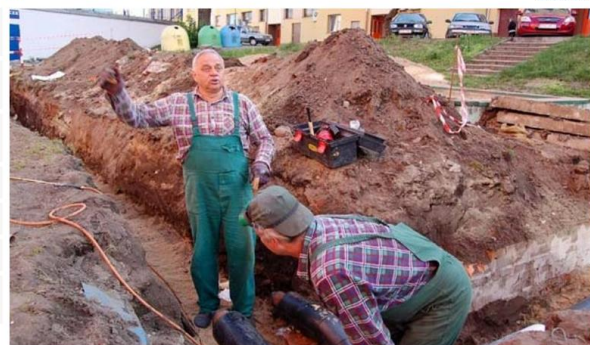
HEC inwestuje m.in. w wymianę przesyłania ciepła kanałami na rzecz rur izolowanych, w których tracą się mniej energii. ©Rajmund Wleń
