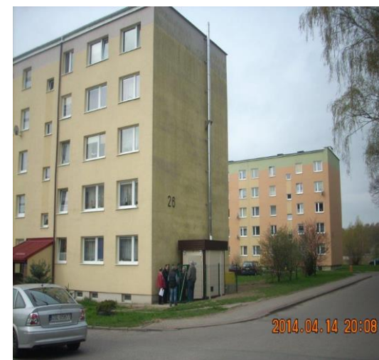
KOTŁOWNIA REJONOWA nr 3
