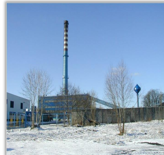
KOTŁOWNIA REJONOWA nr 2
