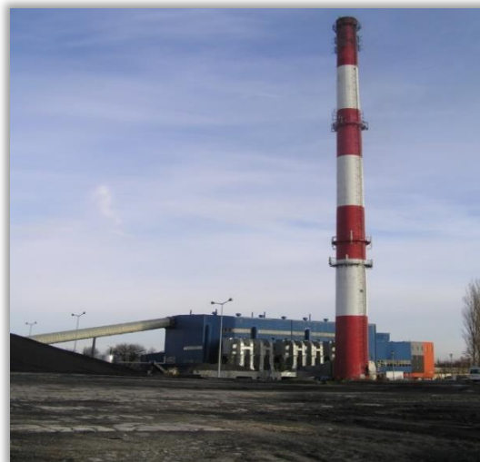
KOTŁOWNIA REJONOWA nr 1
