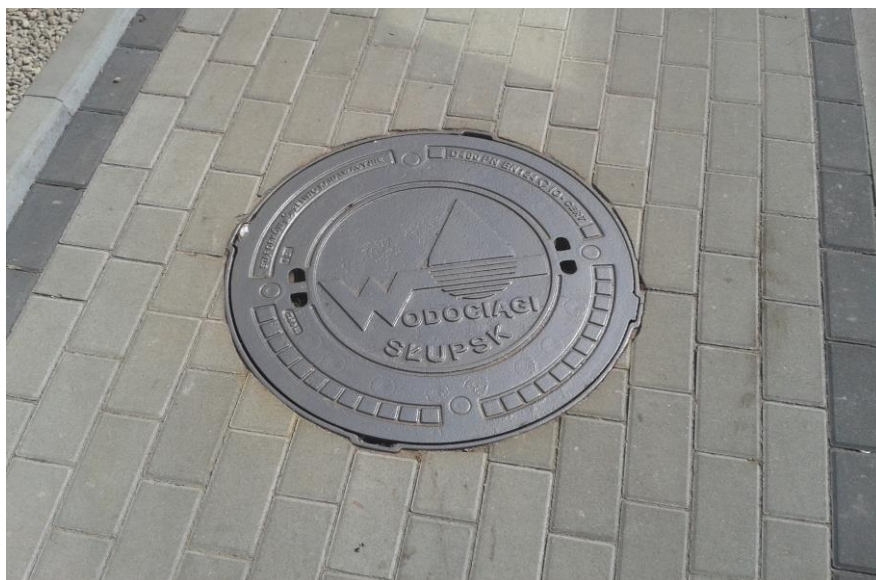
Fot. nr 1. Właz D400 z logo "Wodociągi Słupsk (przykładowa lokalizacja w chodniku)
