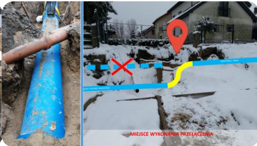
Przebudowa magistrali DN600 [2019]
